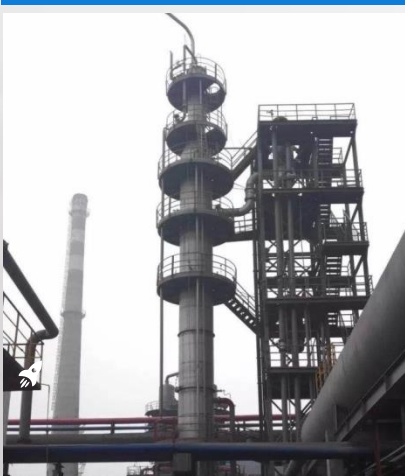
攀钢集团西昌钢铁煤化工厂 氨处理工艺改造项目
